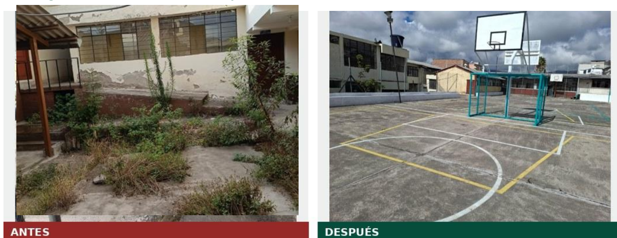
Figura 21. Canchas deportivas: limpieza, pavimento y señalización.
