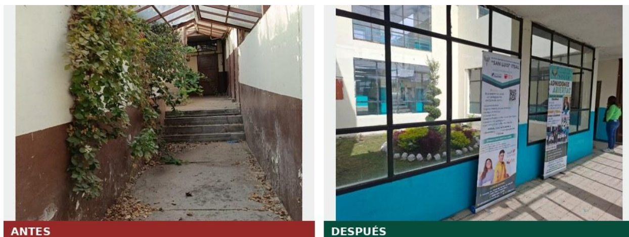
Figura 26. Ingreso y bloque central: rehabilitación integral de la edificación.
